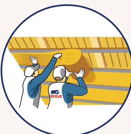
Aplikace minerální izolace URSA DF 35 do přičného kovového roštu upevněného na krovky, jako druhá tepelně izolační vrstva. Izolaci vkládáme lehkým vtláčením po celé délce roštu. Dbejte stejných zásad jako v předešlém aplikačním kroku.
