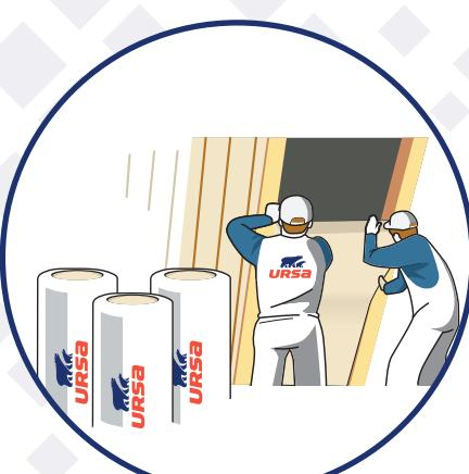
Aplikace minerální izolace URSA PUREONE USF 31 mezi krovky. Izolaci mezi krovky postupně vkládáme lehkým vtlačením po obou stranách její výšky, až zaplníme celé krovkové pole. K zajištění izolace v krovkovém poli je vhodné při aplikaci použít fixační prvky.
