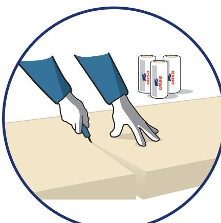
Odřízneme naměřenou část minerální izolace URSA PUREONE USF 31. Řez provádime podél přitlačné lišty (část OSB desky, kovový profil apod.) speciálním nožem URSA určeným k rezání izolace.
